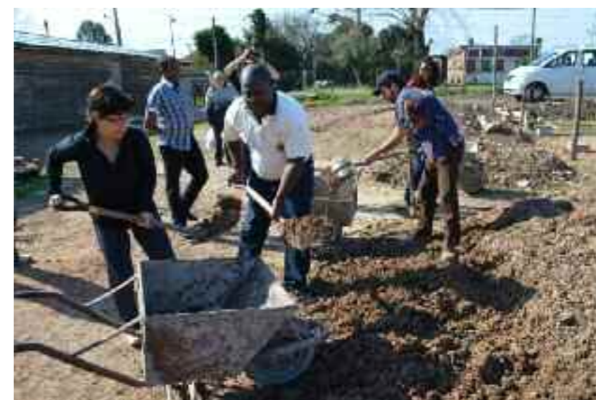
Los participantes se arremangan para ayudar en la construcción
