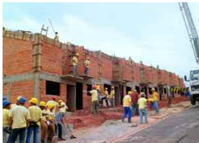
Brasil – Construcción por ayuda mutua con asistencia técnica
