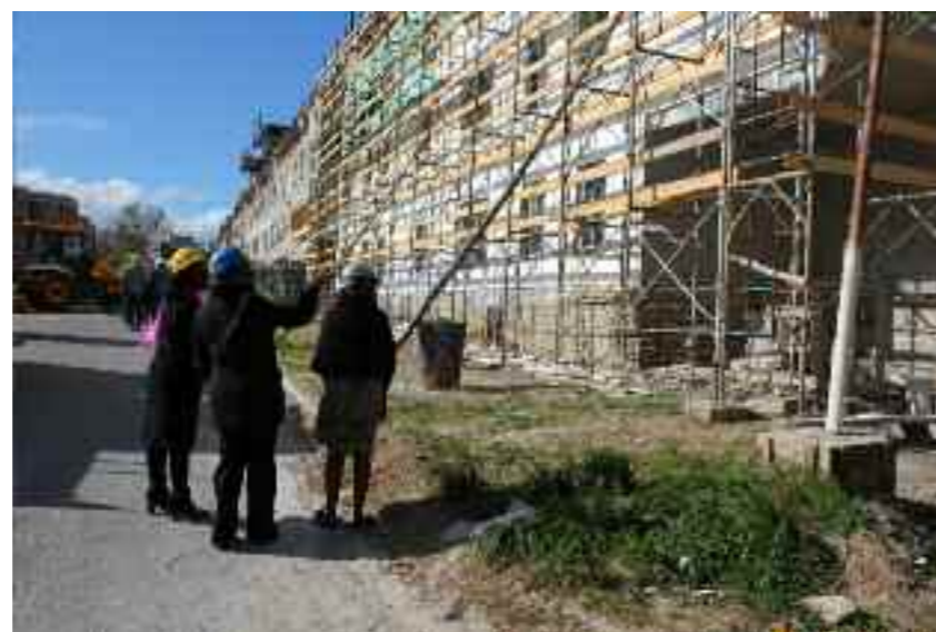
Visita a la construcción de una nueva cooperativa de varias plantas
