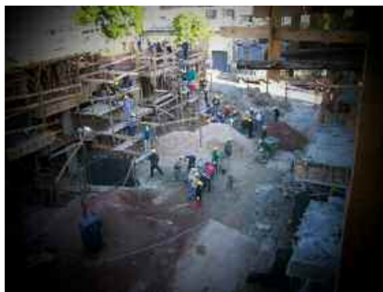
Proceso de construcción en Covireus al Sur, luego de que las estructuras originales en deterioro fueran demolidas, Montevideo
