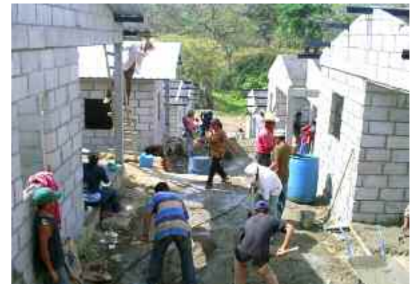
Honduras – Miembros de la cooperativa Casa de Oro construyendo sus viviendas
