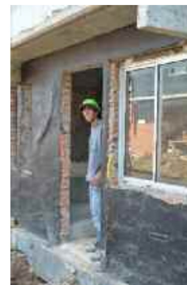
Miembro de la cooperativa en el proceso de construcción
