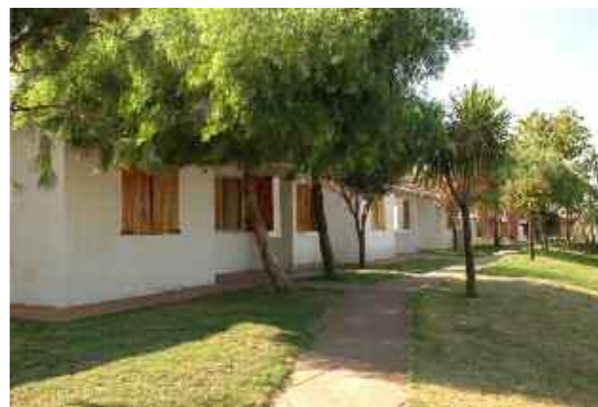
Cooperativa Covimp – desarrollo de vivienda dedicado primariamente, y construido por, personas con discapacidad
