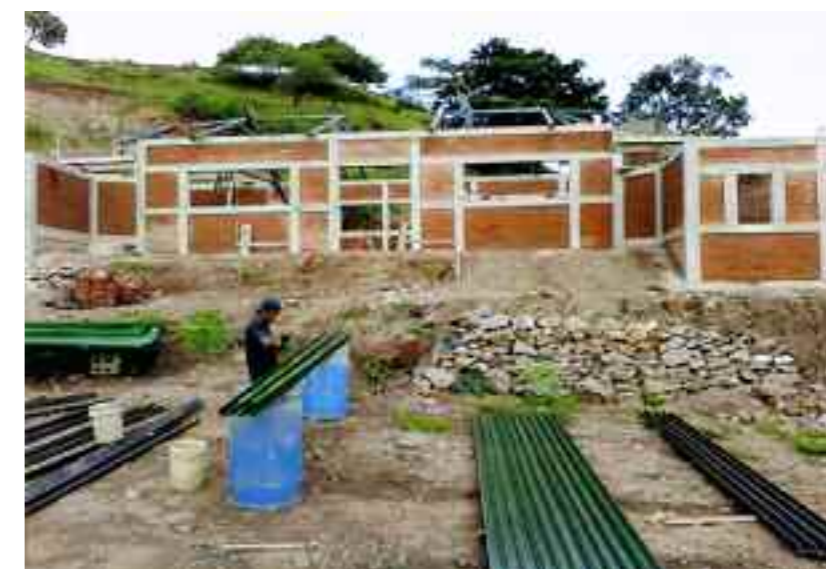
Nicaragua – Cooperativa de vivienda en construcción
